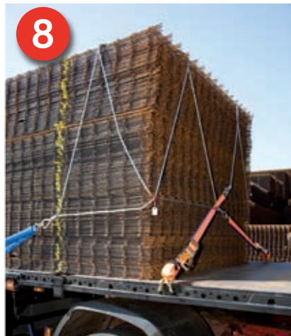
8 An jeder Stapellecke kommt ein DoUniFlex zum Einsatz. Damit ist der Stapel Betonstahlmatten in alle Richtungen ausreichend gesichert.
