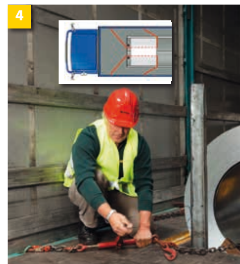
4 Aplicați mijloacele de ancorare (vezi graficul) și asigurați cu ajutorul acestora bobina împotriva alunecării spre spate și rulării în lateral.
